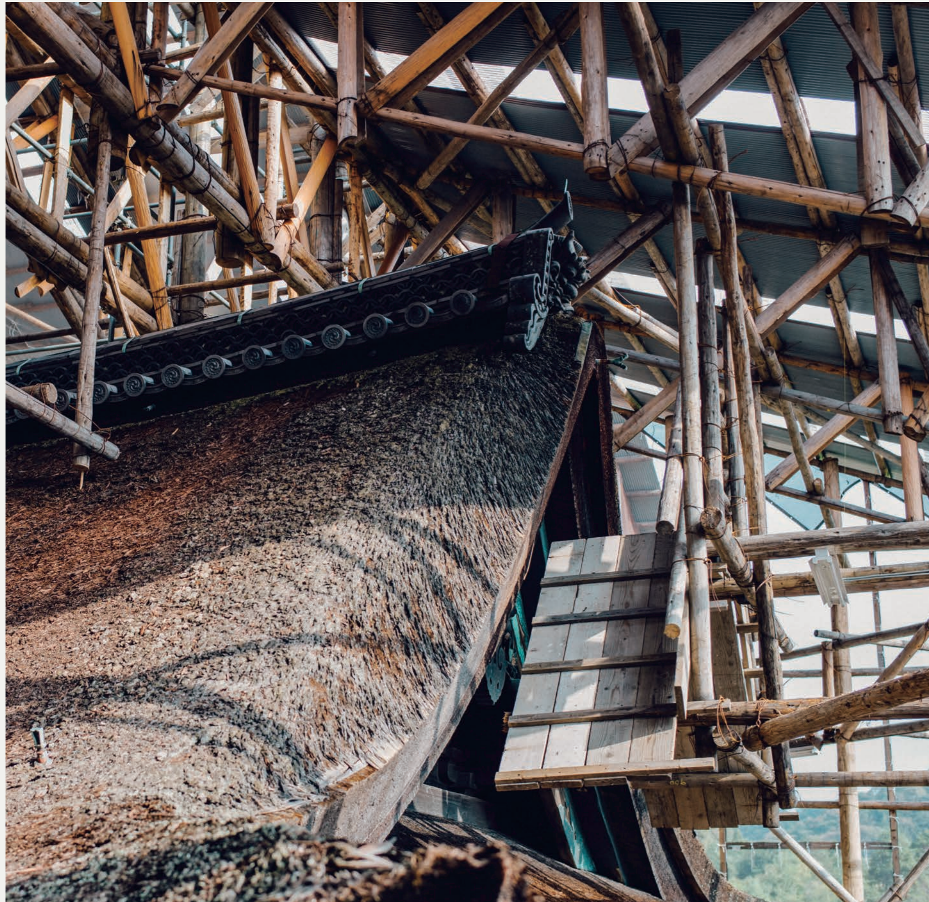
本堂、屋根の葺き替え工事の現場
